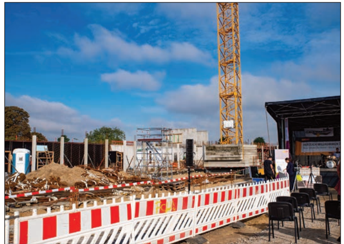
Es kann losgelegt werden: Blick auf die Baustelle der Clay-Oberschule
